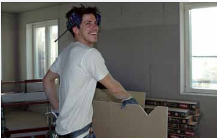
Snickaren Kenneth Arvidsson skär gipsskivor till lägenheterna. Arbetet underlättas av att rätt antal skivor ligger på rätt plats i respektive lägenhet.
