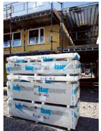
När skivmaterialet är rätt packat från början slipper man stuva om i paketen på byggarbetsplatsen.
