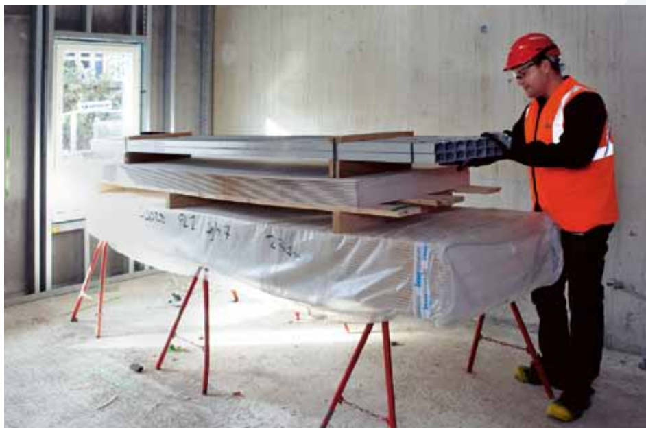
Lägenhetsanpassat spar tid! Här står paketen som innehåller rätt mängd innerväggsgips och stålreglar till just det här boenderummet, förklarar Fredrik Valentinsson från Knauf Danogips.
